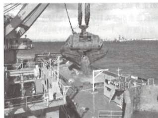
写真-2 浚渫状況 (五祥)
